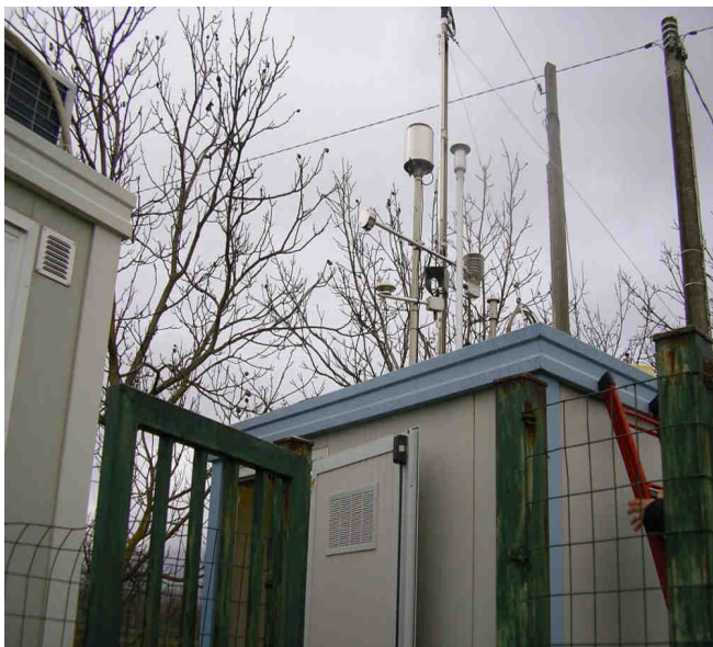
Foto 1- SITO 1a (Centralina qualità dell'aria )
