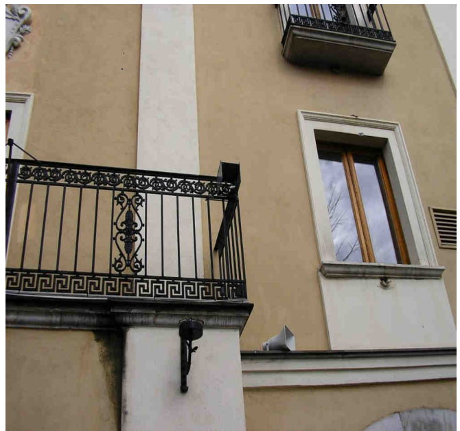
Foto 6- SITO 5 – Viggiano (Palazzo Comunale )
