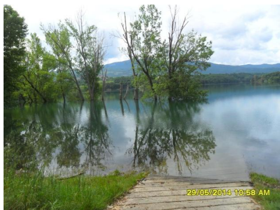
VL5 - Diga prossimità Masseria Crisci
