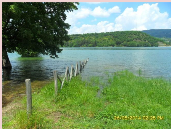
VL3- Diga prossimità Spinoso
