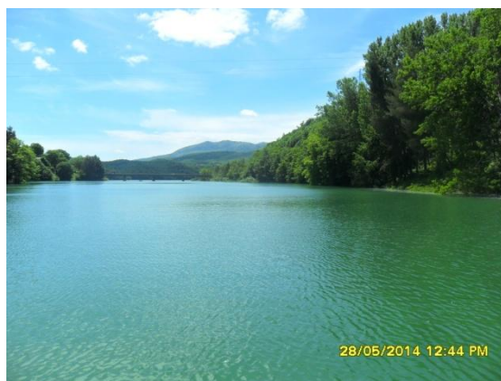
VL6 - Diga prossimità Montemurro
