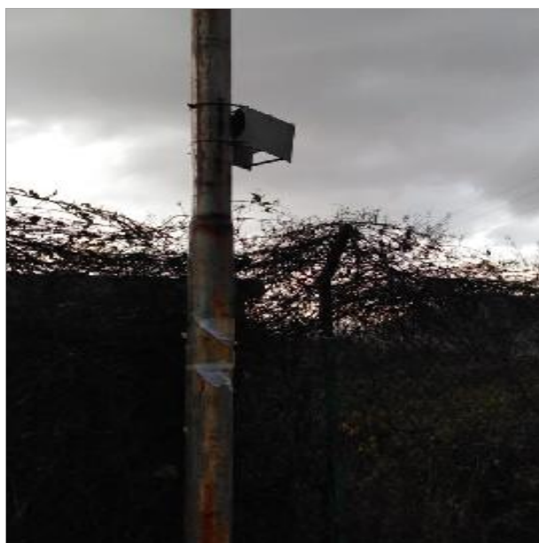
Figura 2.11 – Laurenzana, Strada S.S. 92 - Km 40
