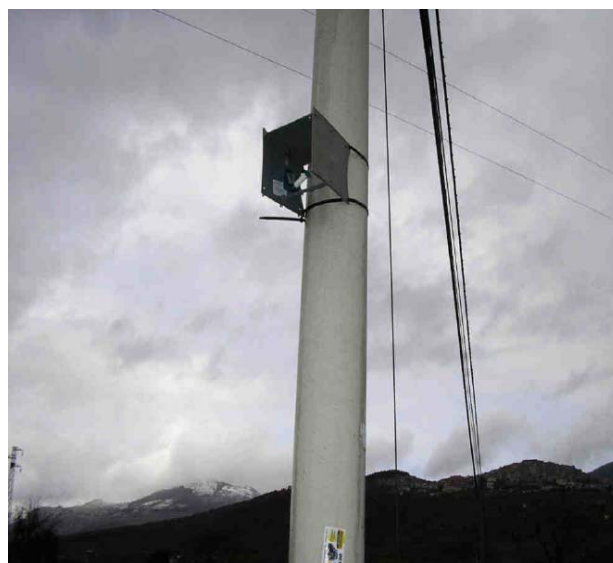
Figura 4.5 - Strada direzione Viggiano, Zona Industriale
