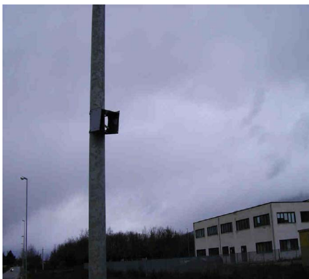
Figura 4.4 - Presso Azienda BRD Legno, Zona Industriale
