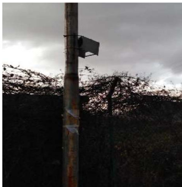
Figura 4.11 - Laurenzana, Strada S.S. 92 - Km 40
