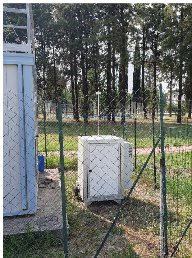
Figura n. 2 Centralina di monitoraggio in continuo H_2S e NH_3
