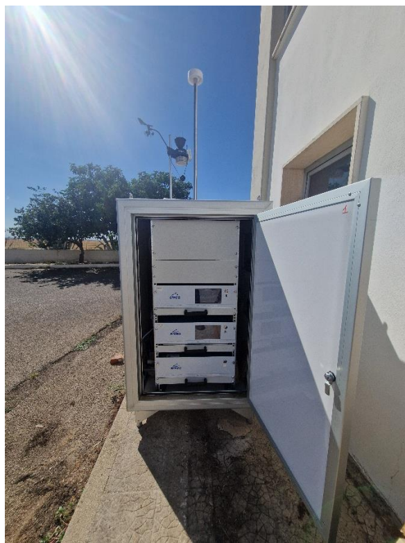
Figura n. 2 Centralina di monitoraggio in continuo di H 2 S e NH 3
