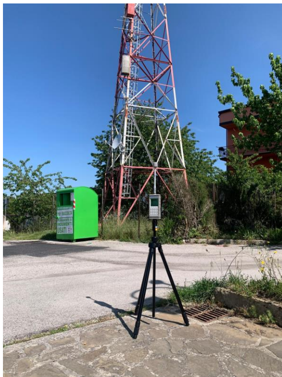
FIGURA 3: PUNTO DI MISURA 1
