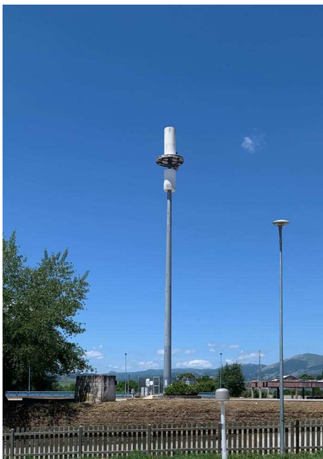
FIGURA 1: FOTO IMPIANTO DI TELEFONIA CELLULARE ESISTENTE
