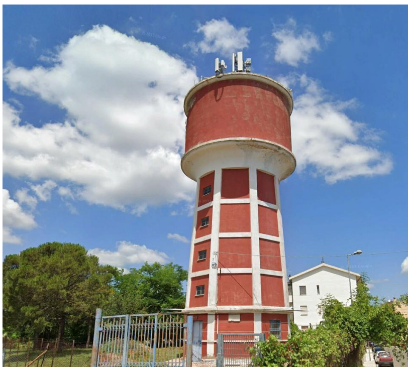
FIGURA 1: FOTO IMPIANTO DI TELEFONIA CELLULARE ESISTENTE
