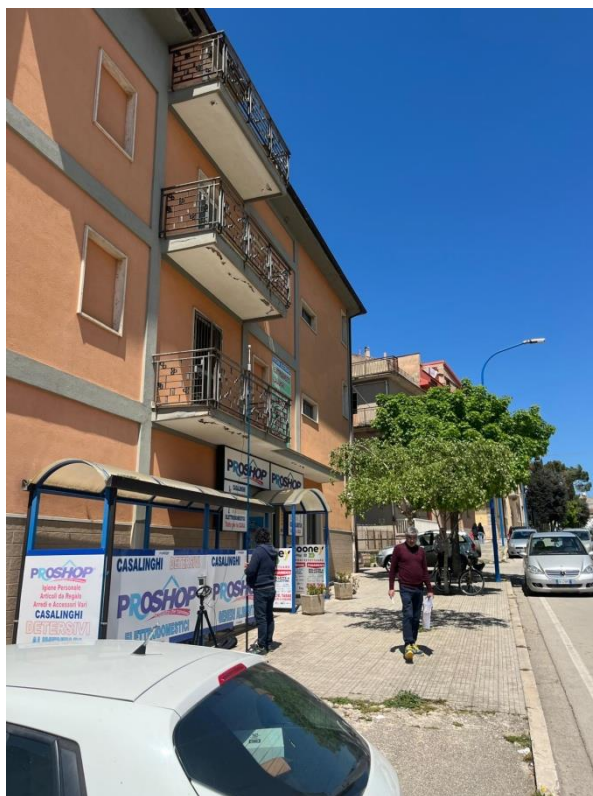
FIGURA 11: PUNTO DI MISURA 9
