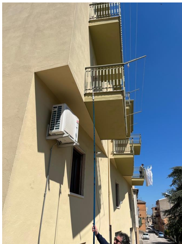
FIGURA 7: PUNTO DI MISURA 5
