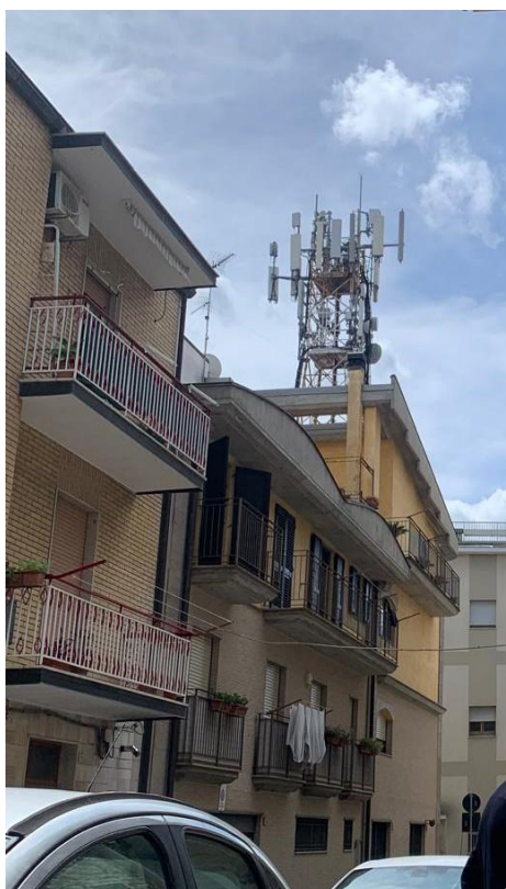
FIGURA 1: FOTO IMPIANTO DI TELEFONIA CELLULARE ESISTENTE
