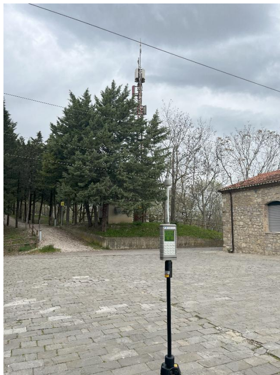
FIGURA 3: PUNTO DI MISURA 1
