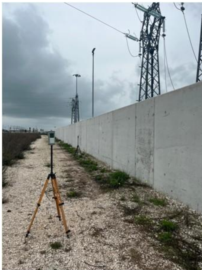
FIGURA 16: PUNTO DI MISURA 10
