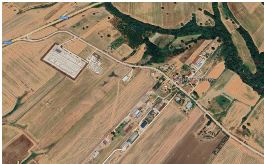
FIGURA 1: FOTO AEREA DELLA STAZIONE ELETTRICA
