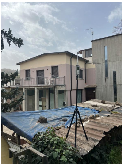
FIGURA 4: PUNTO DI MISURA _ POSIZIONAMENTO STRUMENTO A QUOTA 4.5 M
